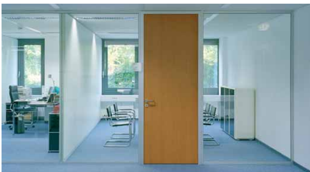
Zarge und flurbündige Alurahmentür mit aufgeklebter Glasscheibe
